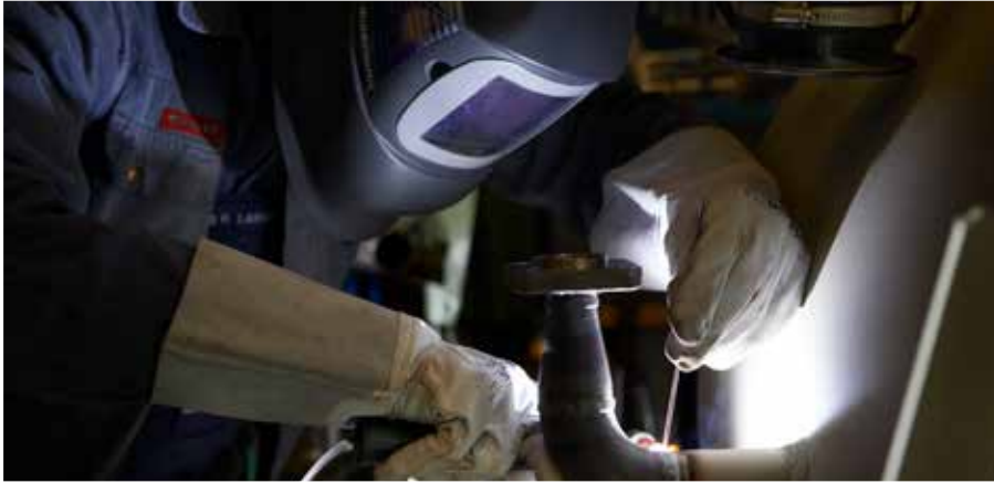
TIG-A-Tack on suunniteltu käytettäväksi austeniittiselle ruostumalle teräkselle.
