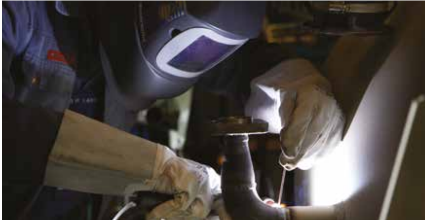
TIG-A-Tack er udviklet til anvendelse i austenitisk rustfrit stål.
