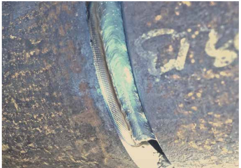
IAC™ – Lodrät fallande svetsning av ett rotsträng i en fjärrvärmelledning. Svetshastigheten ökas betydligt jämfört med traditionell stigande svetsning.
