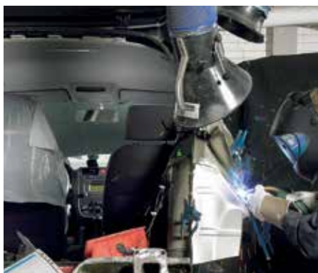
Saldatura MIG/MAG su lamiera
