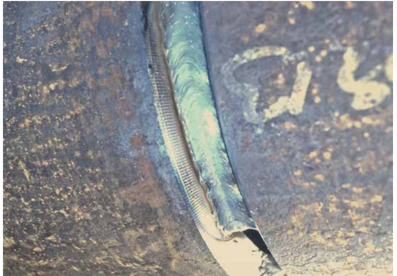
IACT™ senkrecht nach unten gerichtetes Schweißen einer Wurzellage einer Fernwärmeleitung. Deutliche Verbesserung der Schweißgeschwindigkeit verglichen mit dem traditionellen nach oben gerichteten Schweißen.
